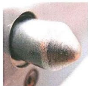
Afdichtingsjoint aan de opdek joint d'étanchement au recouvrement
