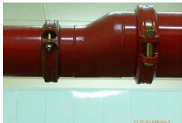
Fig. 13 en 14: Excentrische reducties (Bron: VacTec)
