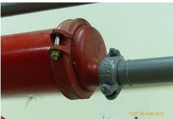
Fig. 13 en 14: Excentrische reducties (Bron: VacTec)
