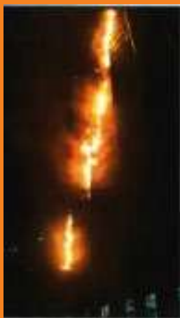
"De nieuwe brandhaarden hebben zich naar boven in het gebouw voortgeplant, waardoor het vlamfront diagonaal door elke gevel van de toren kon bewegen". Fotocredits: Grenfell Inquiry Report
